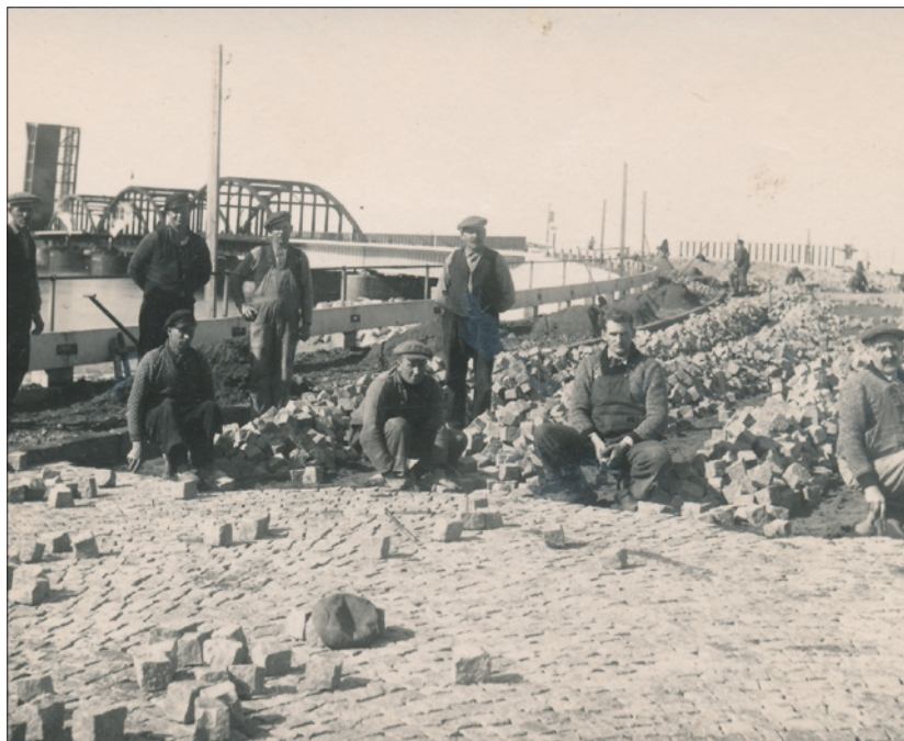
Thyholm blev bundet sammen med det sydlige Danmark, da Oddesundbroen blev indviet i 1938. Her er man i gang med at brolægge hovedvejen færdig til Oddesundbroen.
